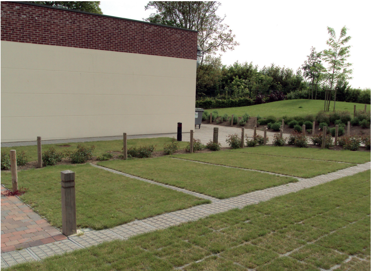
Figure 2 : Parking recouvert de dalles alvéolaires et engazonné.
