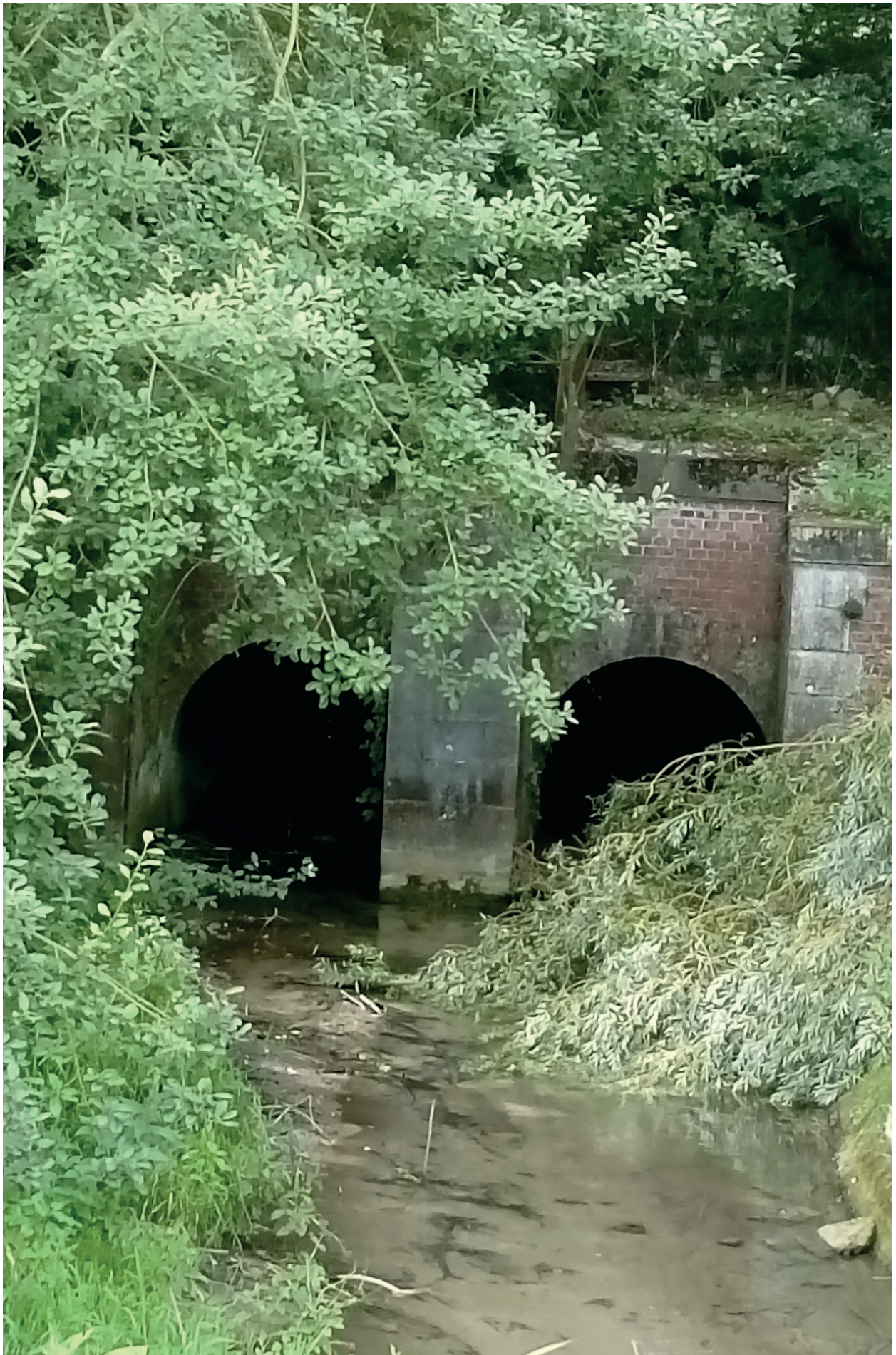
Figure 8 : Passage de l'Agache sous le canal du Nord via un aqueduc.
