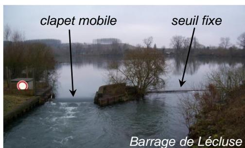
La présence du barrage de Lécuse n'induit pas (crues m01 et m95) ou peu (4 cm pour a08) de surcote en crue par rapport à la situation d'étiage (~20 cm).
